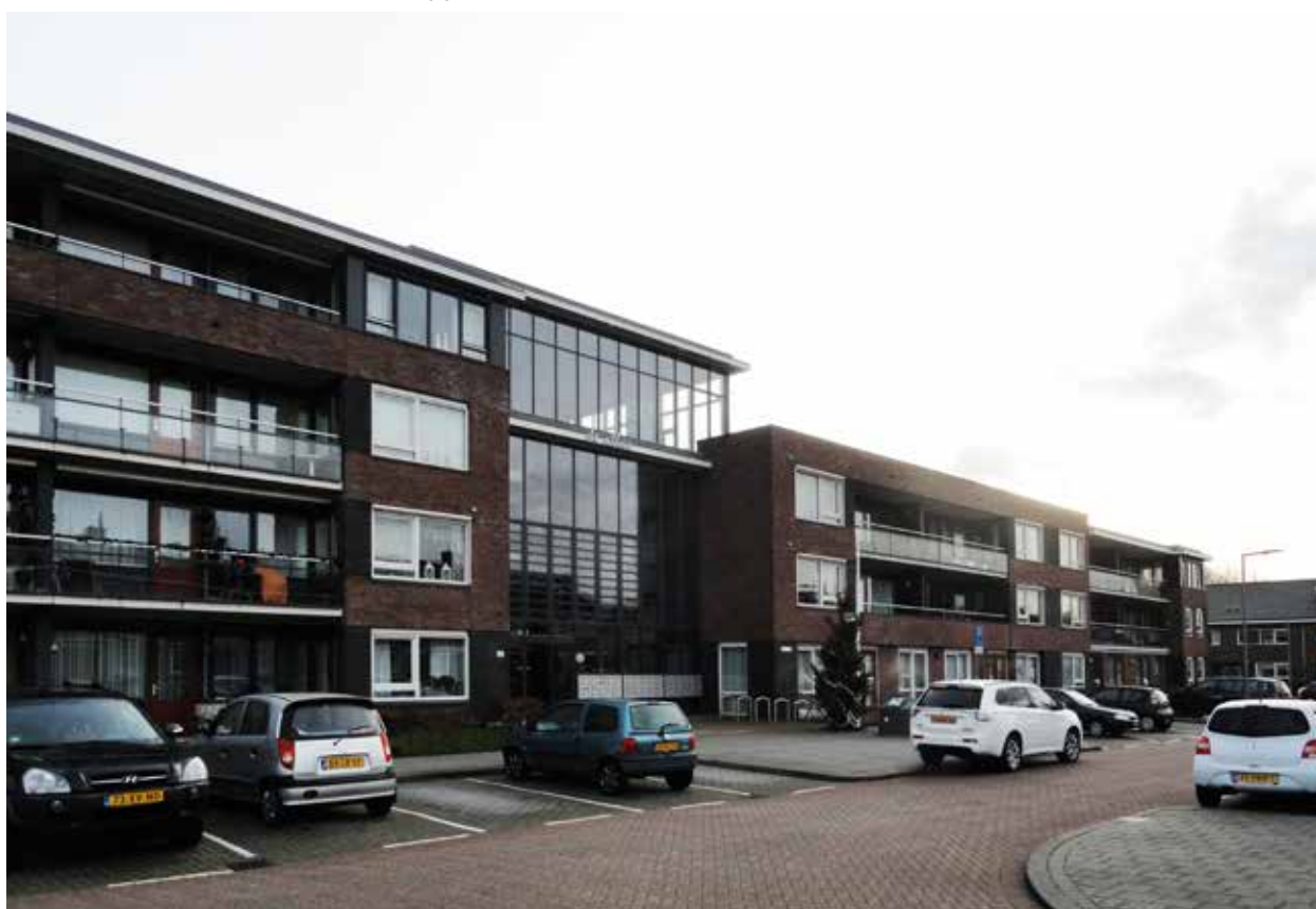
De woningen zijn opgenomen in woonzorgcomplex De Atlas. Foto: Veldacademie, 2014
